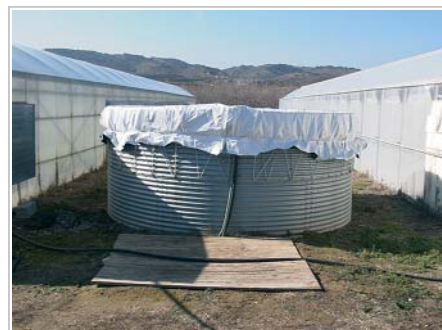
Depósito de almacenamiento de agua, como medio de reserva para la explotación.
