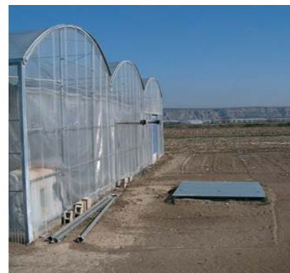
Depósito exterior enterrado para recoger los lixivados por gravedad. (Finca Sartaguda)
